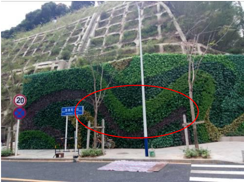
莲塘尾一路边坡覆绿
